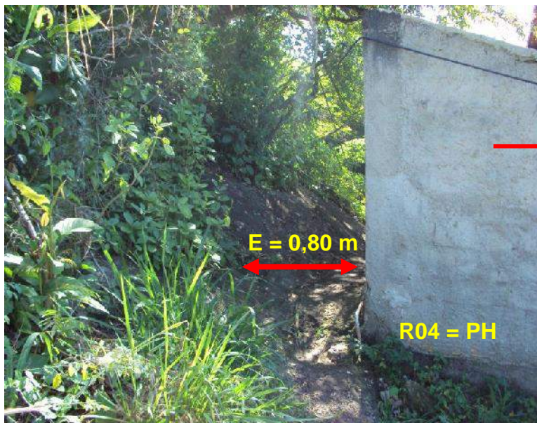
Figura 25 - p04 - Ponto georeferenciado; (D04) - Encosta a ser deslizada; (R04) - Área Receptora ao Movimento de Massa; (ME04) - Massa Vegetada Escorregável, (PH) - Presença Humana, (E) – Distância entre talude e casa construída (PH = R04); e, Vias abertas sobre casas (V04) Fonte: Esse estudo
