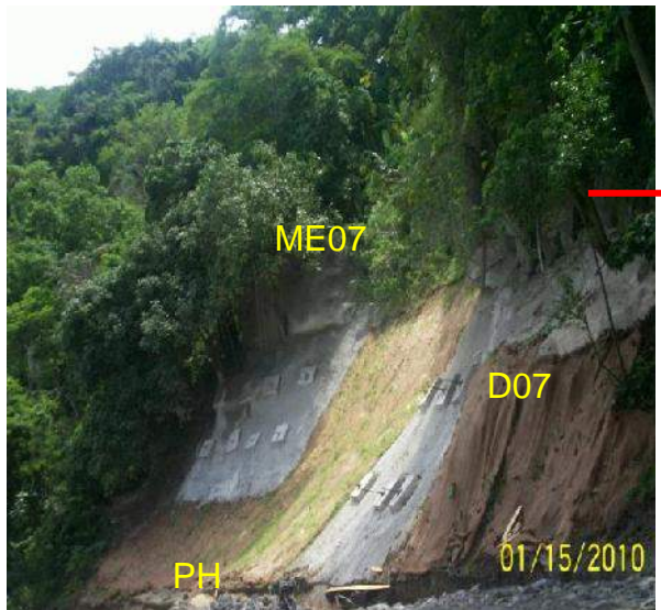
Figura 28 - p07 - Ponto georeferenciado; (D07) – Encosta deslizada e em recuperação; (R07) – Estrada Gilberto de Carvalho receptora ao Movimento de Massas; (ME07) - Massa Vegetada Escorregável, (PH) – Área de circulação automotiva e casas no talude com menor altimetria
